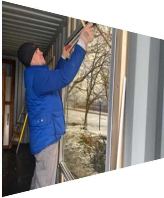
Vgradnja oken po sistemu ind. simboze
