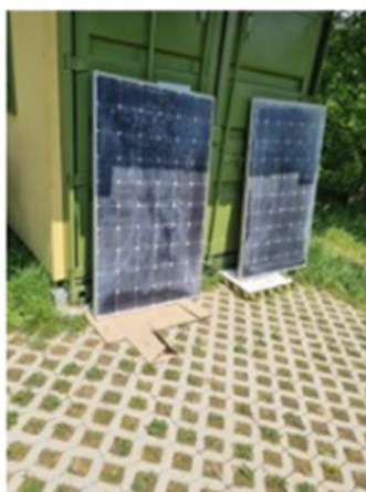
Namestitev solarnih panelov – industrijska simbioza
